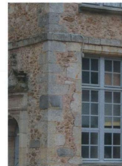
FISSURATION DES MAÇONNERIES À L'ANGLE NORD-OUEST DE L'ANCIENNE CHAPELLE
