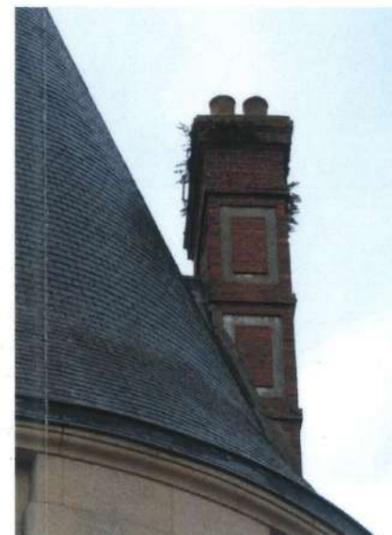
PARTIE HAUTE DES SOUCHES DE CHEMINÉE COLONISÉE PAR LA VÉGÉTATION ; LES SYSTÈMES RACINAIRES CONTRIBUENT À L'OUVERTURE DES JOINTS ET AUX INFILTRATIONS
