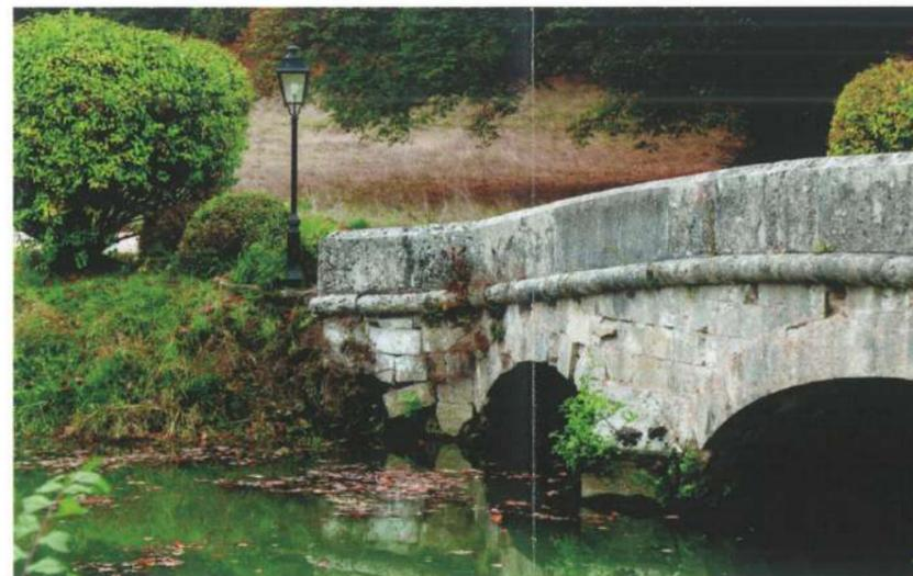
ÀFFAISEMENT DE LA MAÇONNERIE, DISPARITION DES MOELLONS INFÉRIEURS
