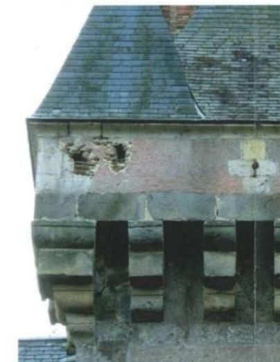
FAÇADE NORD DE LA TOUR-PORCHE, MÂCHICOUIS ET MEURTRIÈRE, ON NOTE LE DÉJOINTOIEMENT ET LES LACUNES DANS LES MAÇONNERIES DE MOELLONS
