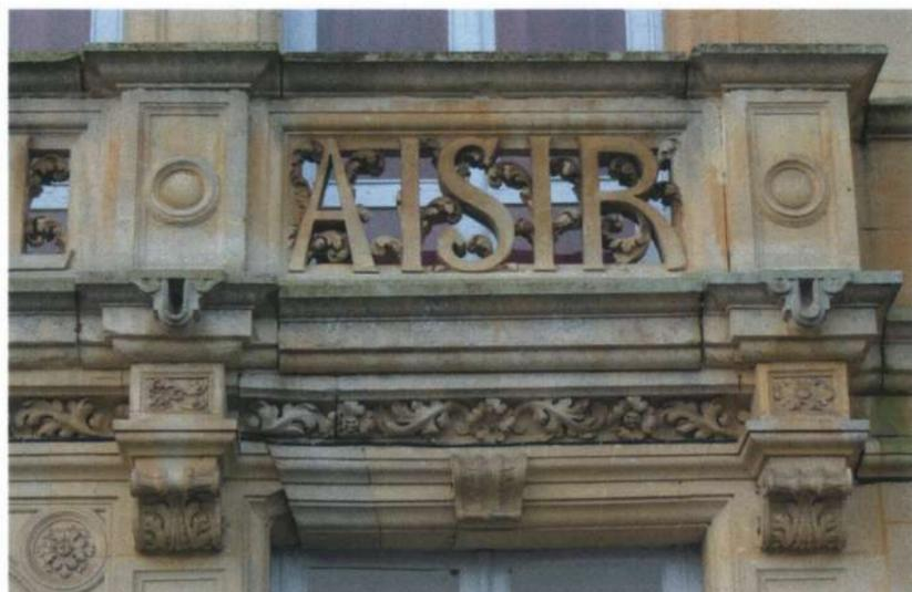
FAÇADE EST DU CHÂTEAU : DÉSORGANISATION DES PIERRES DU BALCON ET DE L'ARC EN PLATE BANDE À L'APLOMB. L'ÉTANCHÉITÉ DÉFAILLANTE DU BALCON FAVORISE LES INFILTRATIONS, LE LESSIVAGE DES JOINTS ET MORTIERS, ET LE DESCÈLEMENT DES PIERRES
