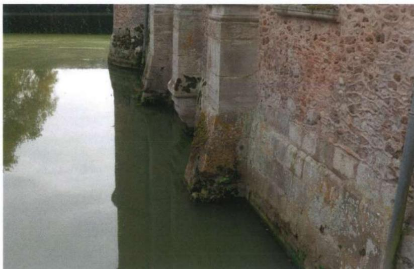
PIEDS DE MAÇONNERIE EN PIERRE DE TAILLE PLONGEANT DANS LES DOUVES : COLONISATION VÉGÉTALE, OUVERTURE DES JOINTS ET DESCÈLEMENT DE PAREMENT CONSÉCUTIFS À L'HUMIDITÉ CONSTANTE
