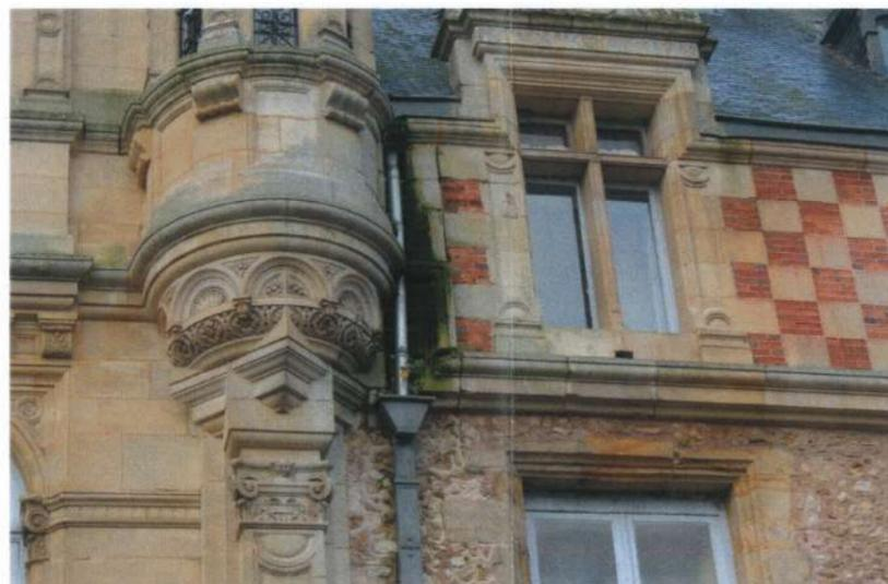
FAÇADE EST DU CHÂTEAU : COLONISATION DE MOUSSES ET D'ALGUES VERTES AUTOUR D'UNE DESCENTE D'EAU PLUVIALE. ON NOTE AUSSI LA VARIATION DE COULEUR (AUREOLES) QUI TRAHIT LA PRÉSENCE CONSTANTE D'HUMIDITÉ DANS LES MAÇONNERIES DE PAREMENT ADJACENTES (MOELLONS ET PIERRES DE TAILLES)
