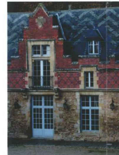
SUPERPOSITION DES MAÇONNERIES EN MOELLONS ET PIERRE, EN BRIQUE À MOTIF EN LOSANGE ET ARDOISE À MOTIF EN CHEVRON
