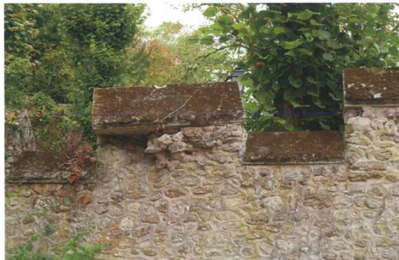
MUR DE CLÔTURE À MERLONS. ON NOTE LA DÉSORGANISATION DES MAÇONNERIES
