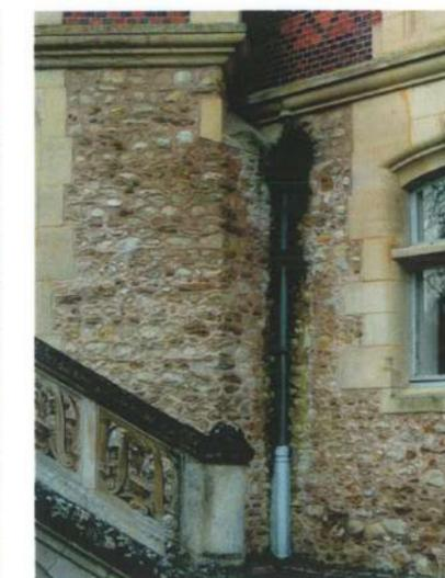
FAÇADE SUD DE L'ANCIENNE LAITERIE, VÉGÉTATION ET MOUSSE AUTOUR D'UNE DESCENTE D'EAU PLUVIALE
