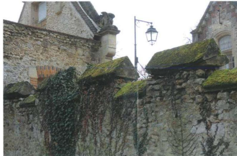
MUR DE CLÔTURE À MERLONS. ON VOIT ICI L'ÉTAT DE DÉGRADATION AVANCÉE DE CERTAINS ÉLÉMENTS DE COURONNEMENT
