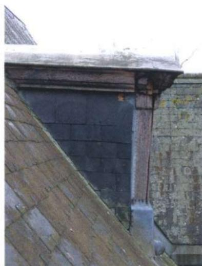
LUCARNE HAUTE : EXPOSITION PROLONGÉE DES BOIS DU CHÂSSIS DE LUCARNE ENTRAÎNANT DES TRACES NOIRES D'HUMIDITÉ, LE POURRISSÉMENT ET LA RUPTURE DES ASSEMBLAGES
