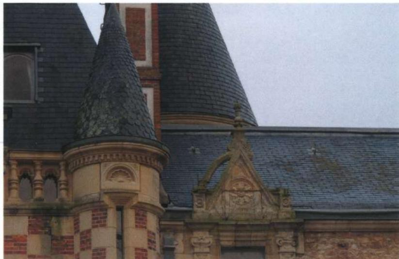
COUVERTURE ET ÉLÉMENTS EN PIERRE DE TAILLE DE LA FAÇADE SUD DU CHÂTEAU. ON NOTE LE DÉJOINTOIEMENT OU LE DESCÈLEMENT DE CES ÉLÉMENTS ET LEUR COLONISATION PROGRESSIVE PAR LA VÉGÉTATION
